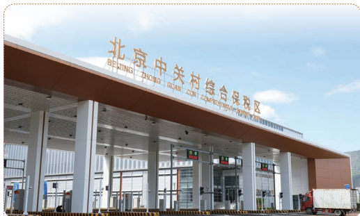
中关村综保区二期项目主体结构 全面封顶
